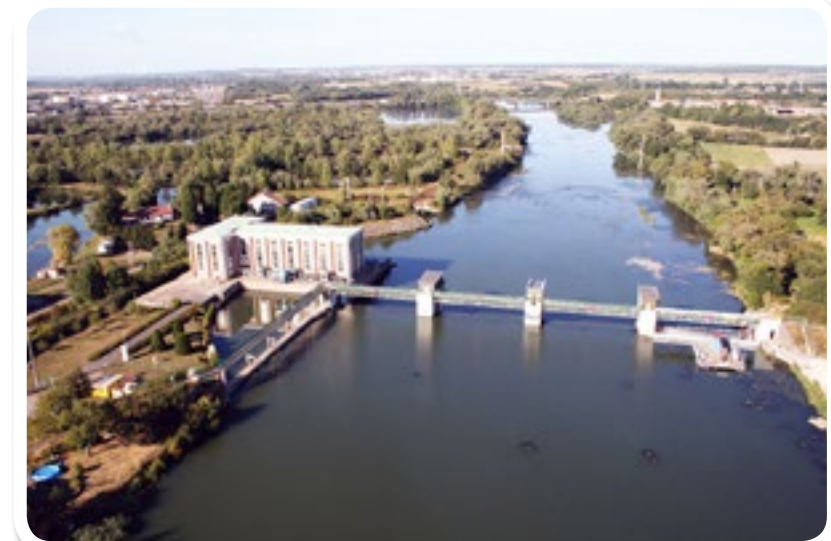
Barrage hydro-électrique d'Argancy.
