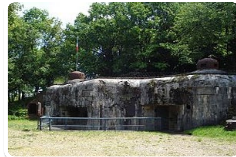
Le bloc 3 de l'ouvrage du Bambesch près de Bambiderstroff.
